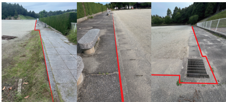
15-16H - 車道側の OB ライン (アスファルト舗装路)
